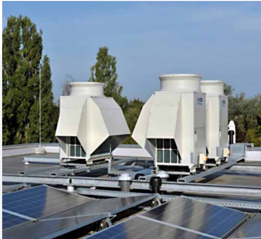
Die VRF-Außengeräte aus der City Multi-Serie von Mitsubishi Electric zeichnen sich durch Spitzenwerte bei der Energieeffizienz und eine sehr hohe Betriebssicherheit aus.
